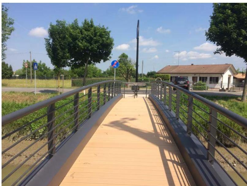
**Foto n. 05** – Vista di pavimentazione in doghe di legno fibro composte
